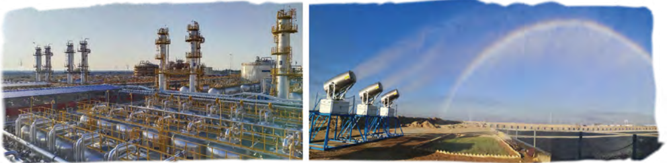
米桑油田终端厂水处理区域
