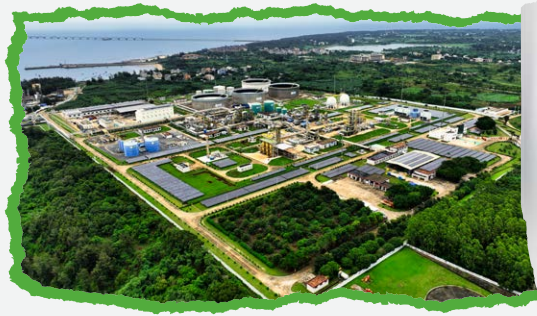
澗洲油田群光伏電站
